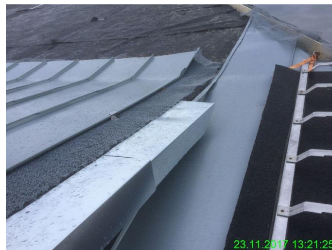
Zusammenfügen der einzelnen Flächenelemente
