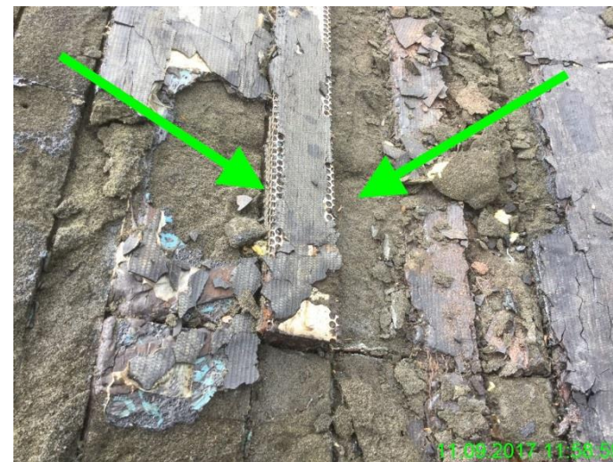
Blick auf die eingeschlagenen Haftschienen
