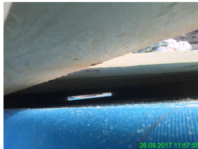
Durchgängige Belüftung
