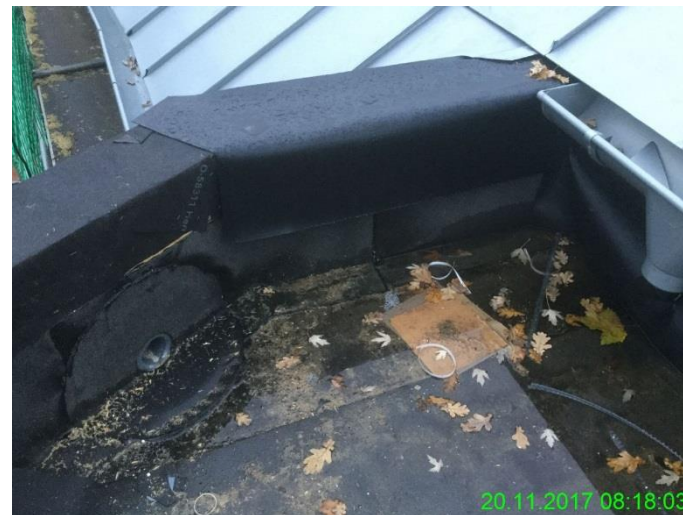
Konstruktion einer klaren Flächentrennung und Wasserführung
