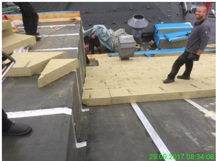
Anarbeiten an die Gaube
