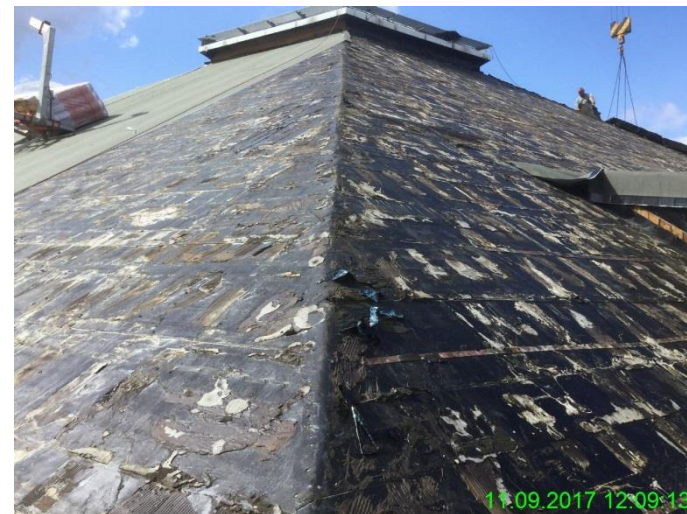
Verbleib der ersten Sperrschicht auf der Rauhspundschalung
