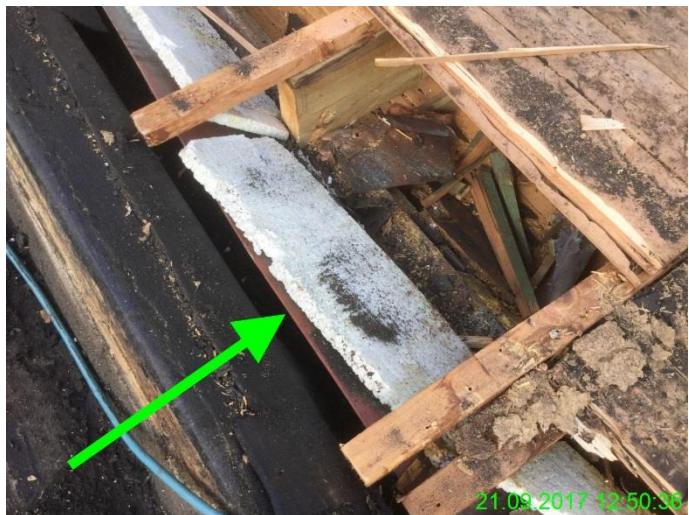
Ehemalige Dachrinne des ursprünglichen Baukörpers
