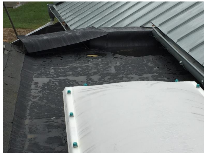
Flachdachanschlusshöhen mit entsprechenden Stauhöhen
