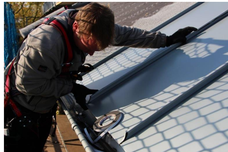
Einlage mit Dichtungsband
