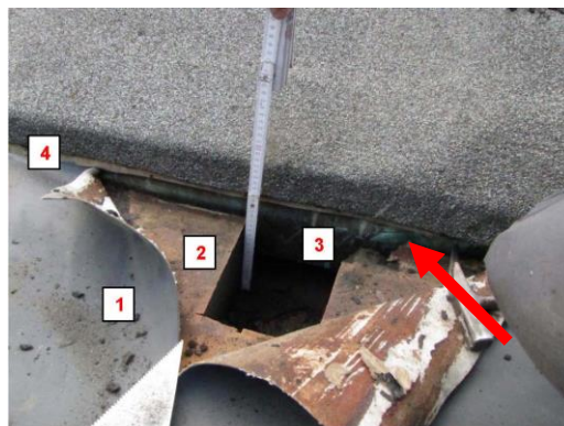
1: Kunststofffolienabdichtung 2: Schaumglasdämmung 3: Kupfertraufblech 4: bituminöse Abdichtung des Zeltdaches
