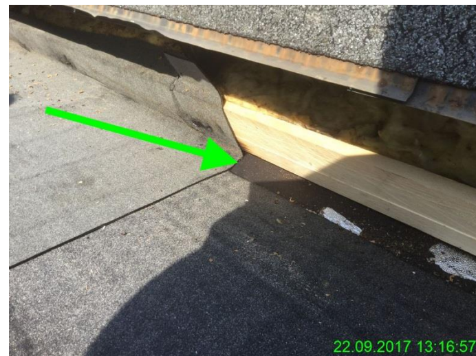
Anschluss der Dampfsperre an die verbleibende Konstruktion
