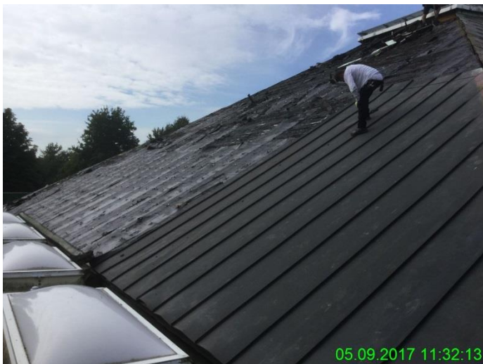
Teilabriss der Kupferschicht
