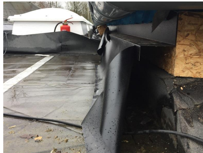
Blick in die neue Konstruktionshöhe vom Hauptdach zum Flachdachteil
