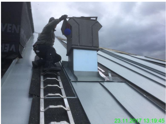
Einbindung der Anbauteile
