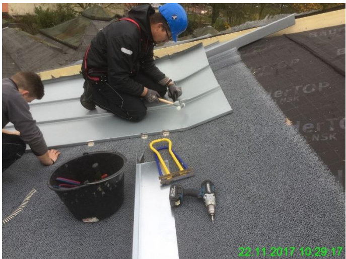
Übergang Gaubendach 15° zum Hauptdach 30°
