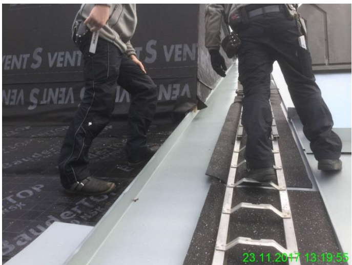
Anarbeitung Hauptdachfläche an Gaubenseitenwand
