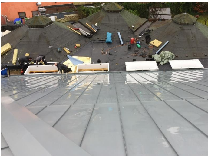
Gestufte Eindeckung mit fertiger Gratabdeckung
