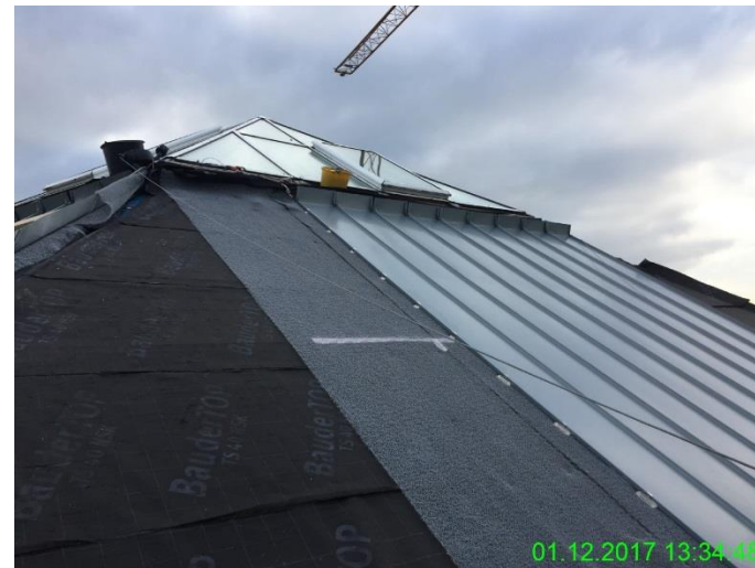
Blick auf die Scharenverlegung inkl. Strukturunterlegbahn
