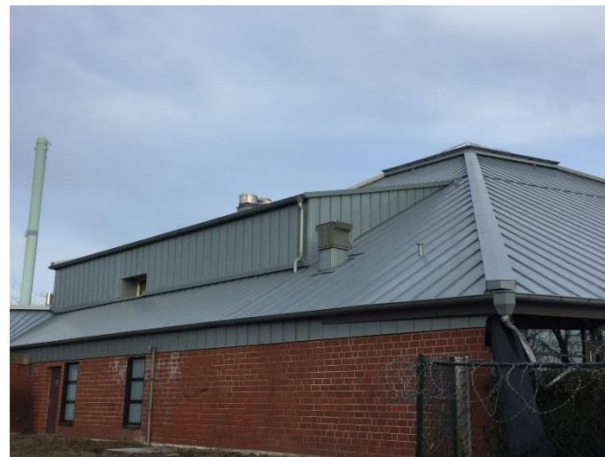
Fertige Dachflächen inkl. Übergängen
