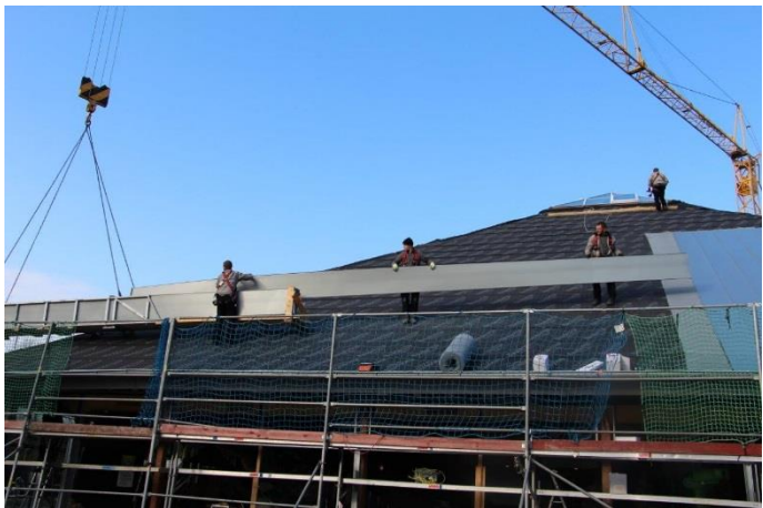
Einschwenken der Blechpakete
