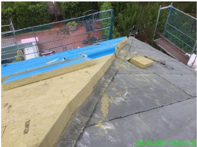
Auflegen des neuen Dämmpaketes
