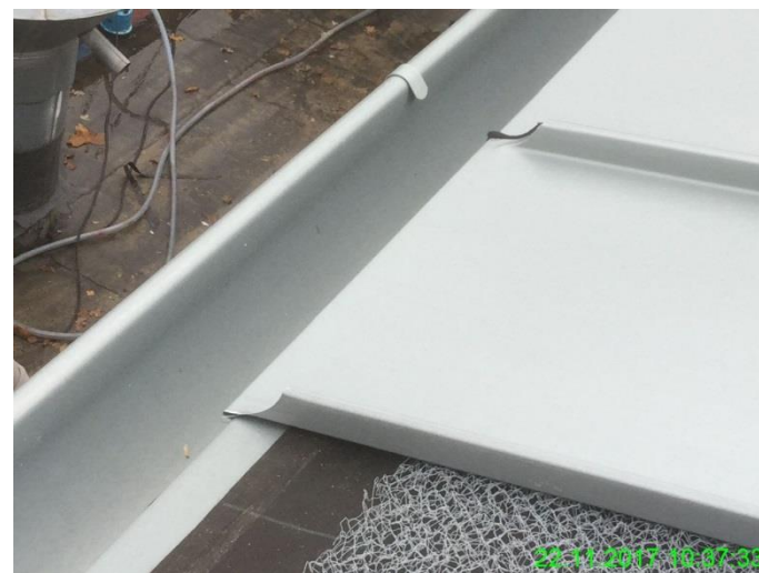
Traufpunkt mit Längenausgleich und Strukturbahn
