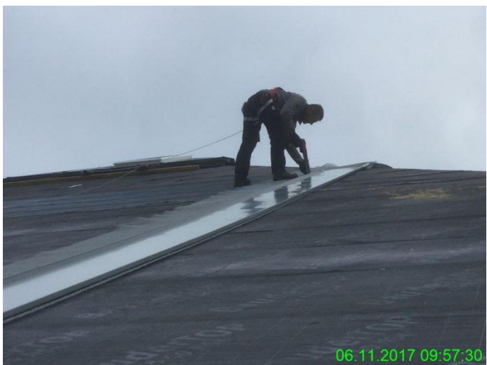
Befestigung nach Haftenplan
