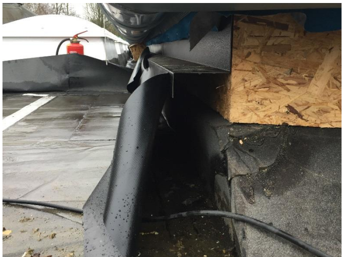
Konstruktion einer ausreichenden Anschlusshöhe
