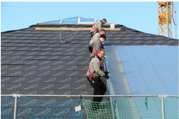
Auflage der Bleche
