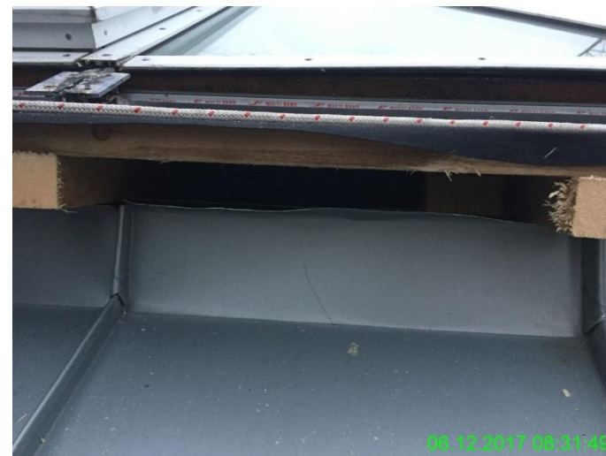
Belüftungsausstritt an der Kuppel
