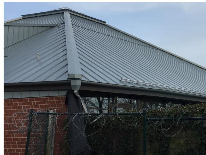
Hauptdachflächen mit Belüftungselementen
