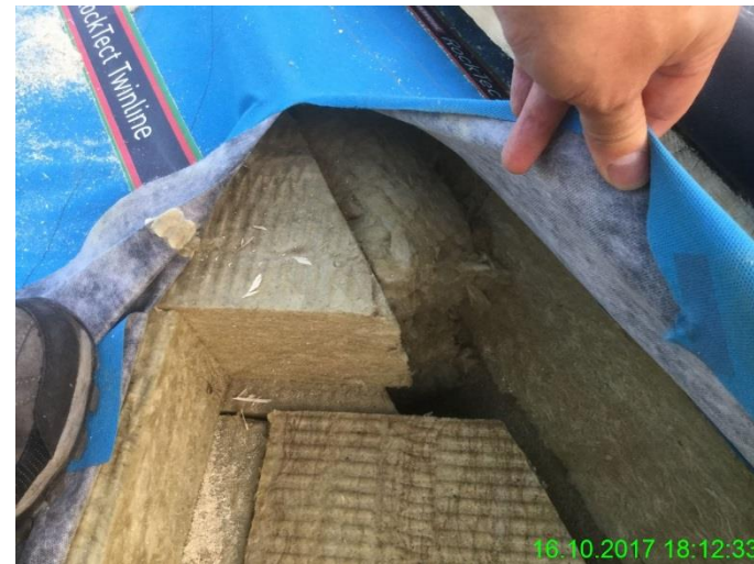
Schließen der Gratkanten
