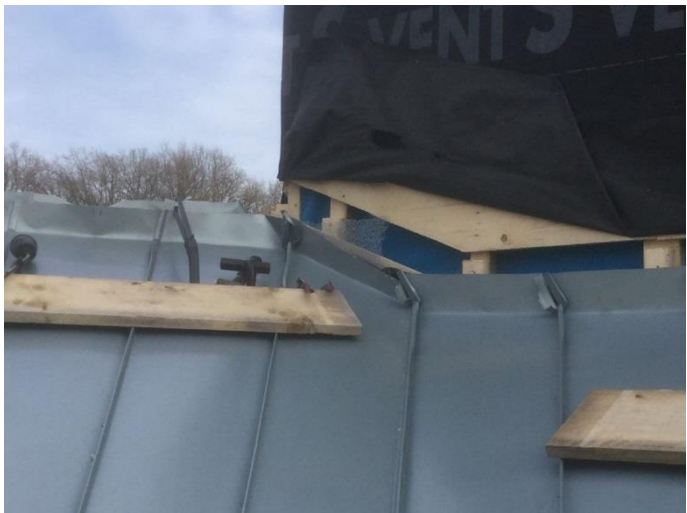
Flächenführung Hauptdachfläche vor dem Gaubenelemente im Firstbereich des Vorbaus
