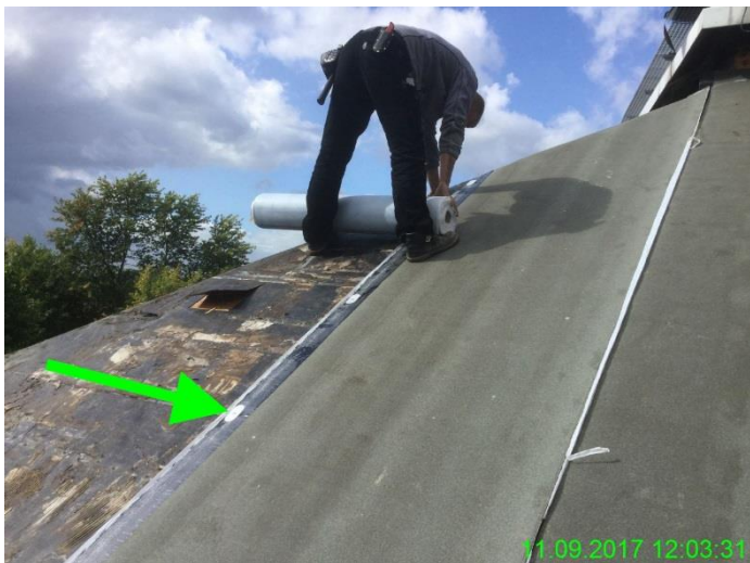
Aufbringen der neuen Dampfsperre inkl. mechanischer Befestigung
