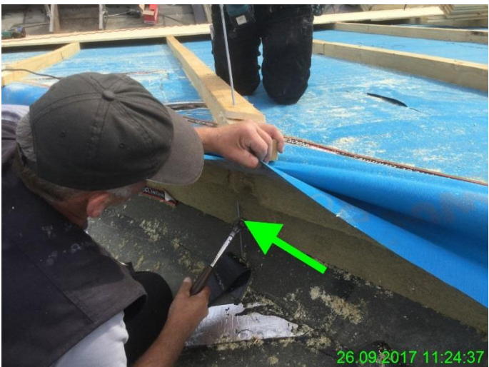
Kontrolle der Verschraubungen
