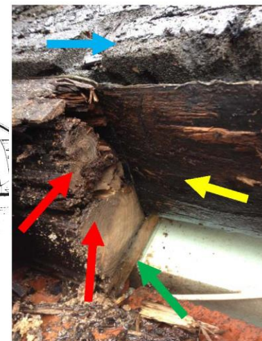
Roter Pfeil: 8 X 8 Kantholz grüner Pfeil: gespundete Schalung gelber Pfeil: bituminöse Dampfsperre blauer Pfeil: Schaumglasdämmung
