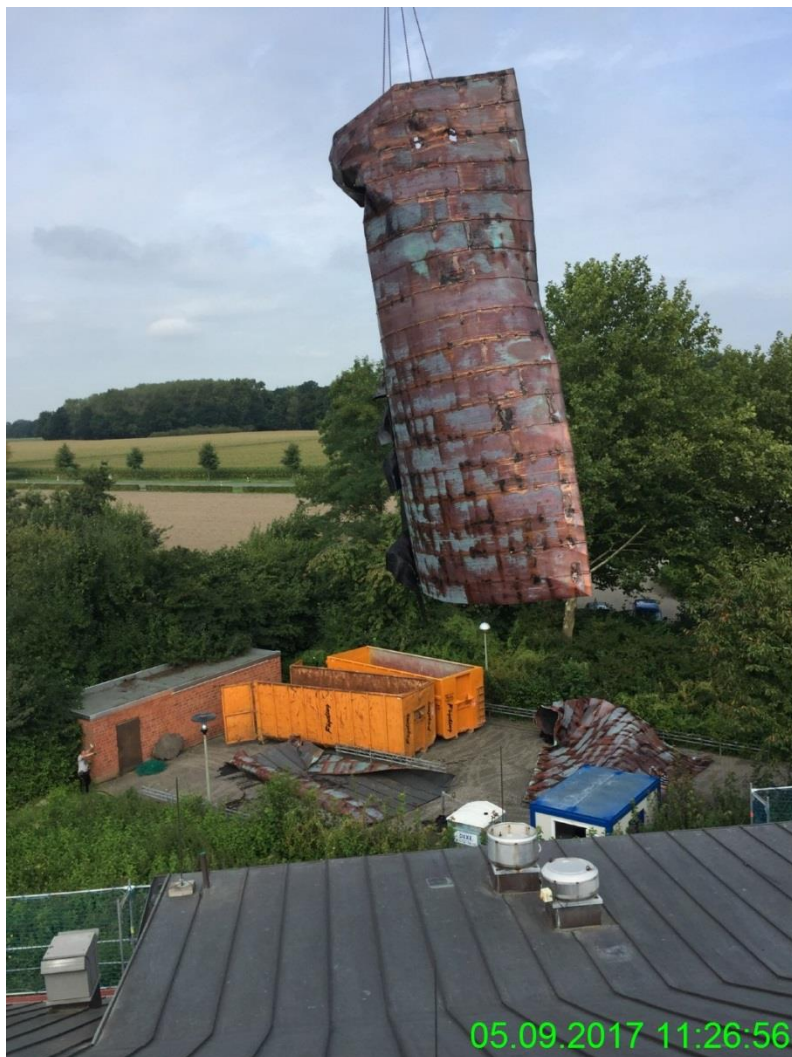
Lösen der Blechabdeckung mittels Kran und Schneidgerät
