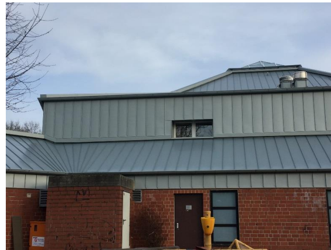
Fertige Dachflächen inkl. Übergängen
