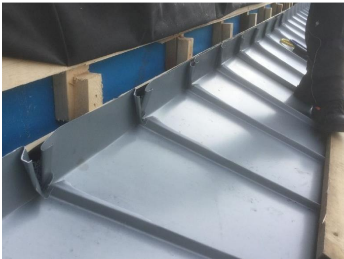
Aufgestellte Scharen im Anschlussbereich zur Gaube Durchgehende Belüftung
