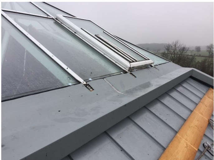
Abdeckung des Kuppelanschlusses
