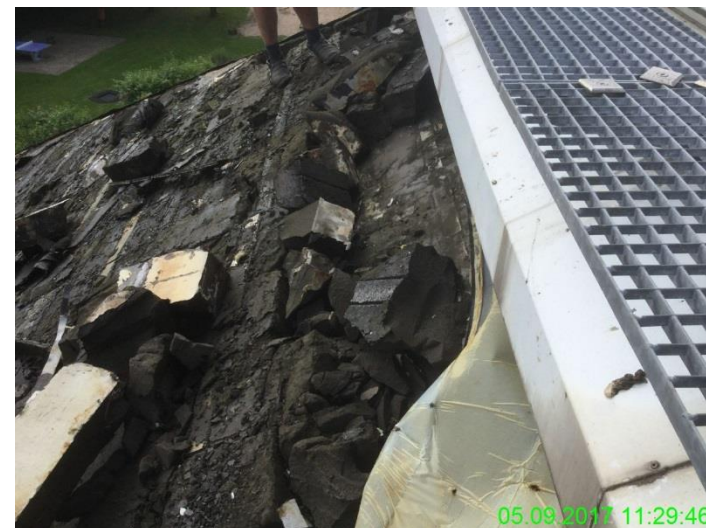
Lösen des Foamglasdämmstoffes
