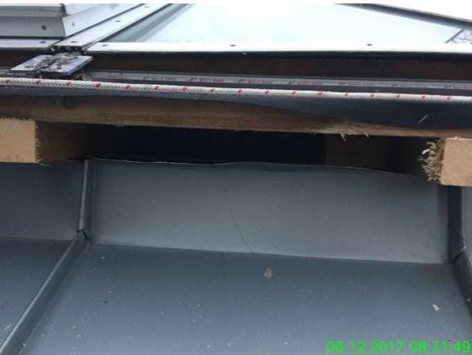
Belüftungsebene
