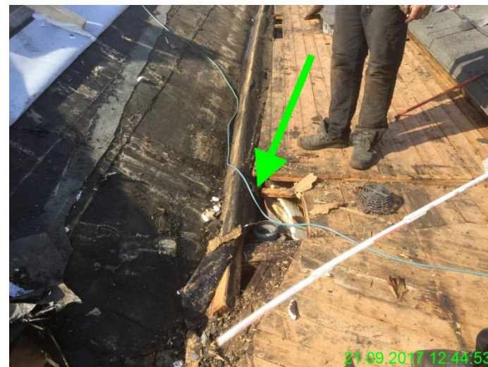
Fortführung der Dampfsperre vom Hauptdach, über den Flachdachteil zum verbleibenden Zeltdach
