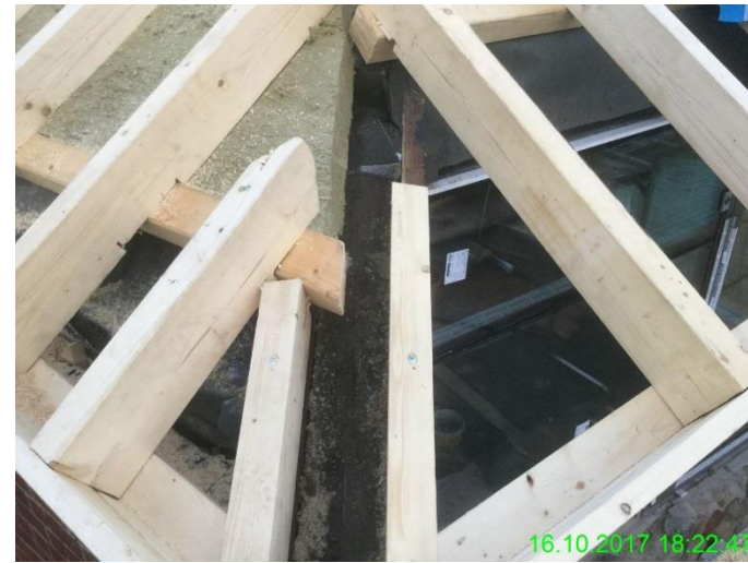
Montage des neues Dachrandes
