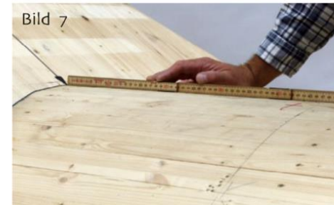
Firstlänge messen bei Metalldachdeckung: Vom Ortgang bis zum Kehlknick.
