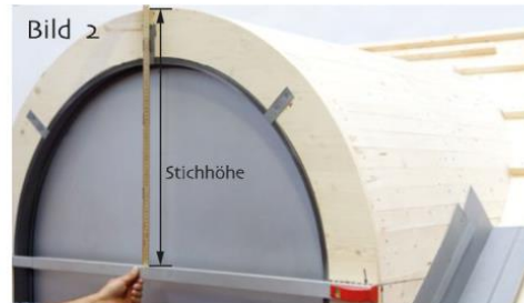
Stichhöhe von der Gaubenmitte bis zur Oberkante Schalung messen (zuzüglich Strukturmatte).
