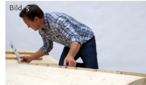
Firstlänge messen bei Ziegeldachdeckung: Vom Ortgang bis Oberkante Dachlattung.
