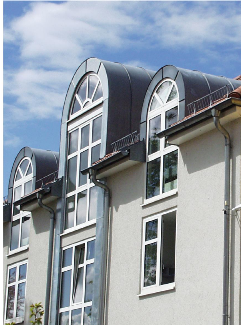
Wohn- und Geschäftshaus, Herrsching am Ammersee
