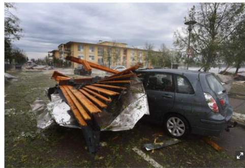
Ein vom Sturm abgetragenes Dach eines Seniorenheims liegt auf einem Parkplatz auf einem Auto. © dpa / Karl-Josef Hildenbrand/dpa
